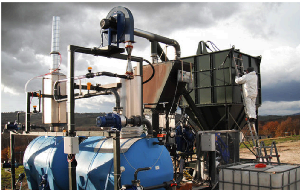
L'impianto di 3P Engineering che consente di trasformare letame in energia e fertilizzante
